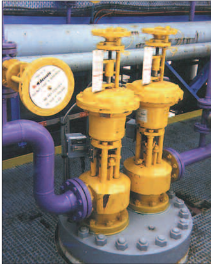
Приводы В1940 устанавливаются на клапане модели 2200 – изоляция емкости аммиака ( \text{NH}_3 )
