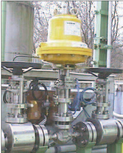
Привод В1940 на клапане модели 2100В - разгрузочная станция кобальта
