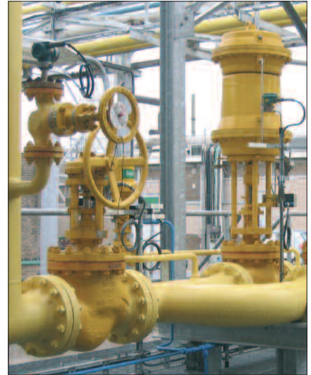
Сдвоенные приводы на модели 2100 ВАТ – для жидкого хлора
